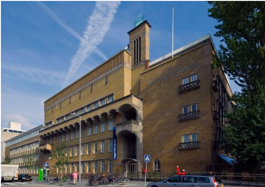
Architect: gebruik van ritme, toren, minimalistische decoratie en verspringende volumes
