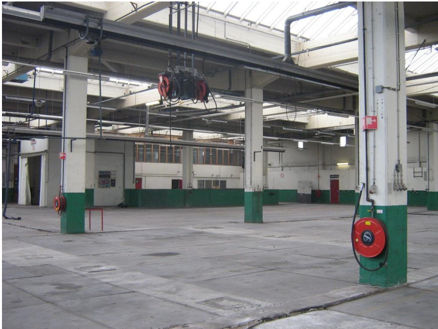
Gebouwanalyse: dominerende constructie
